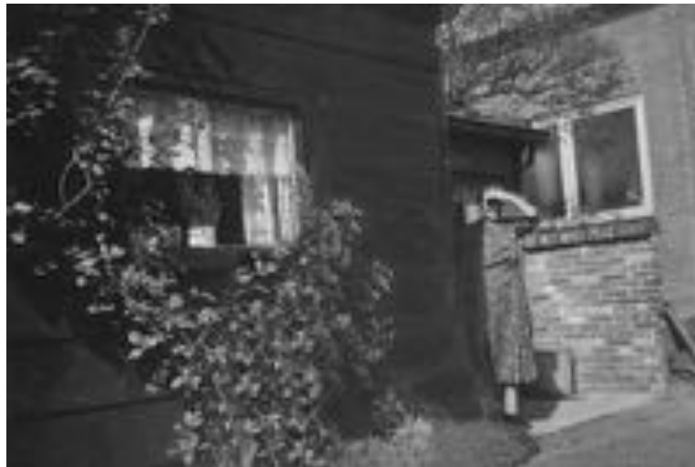
Neeltje Nootenboom-Struijk voor de noodwoning, rechts de achterkant van de naoorlogse garage
