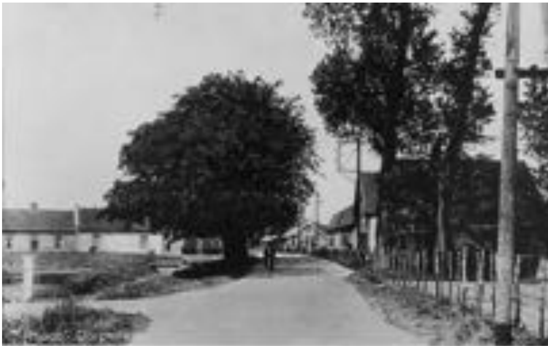
Naast Verhoef waren in mei 1940 zes nieuwe huizen in aanbouw.
